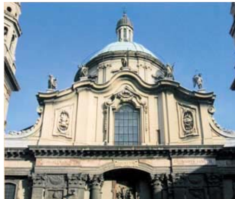
Milàn, Iglesia de San Alejandro: parte superior de la fachada.
