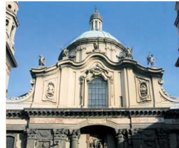
Milán, Iglesia de San Alejandro: parte superior de la fachada.
