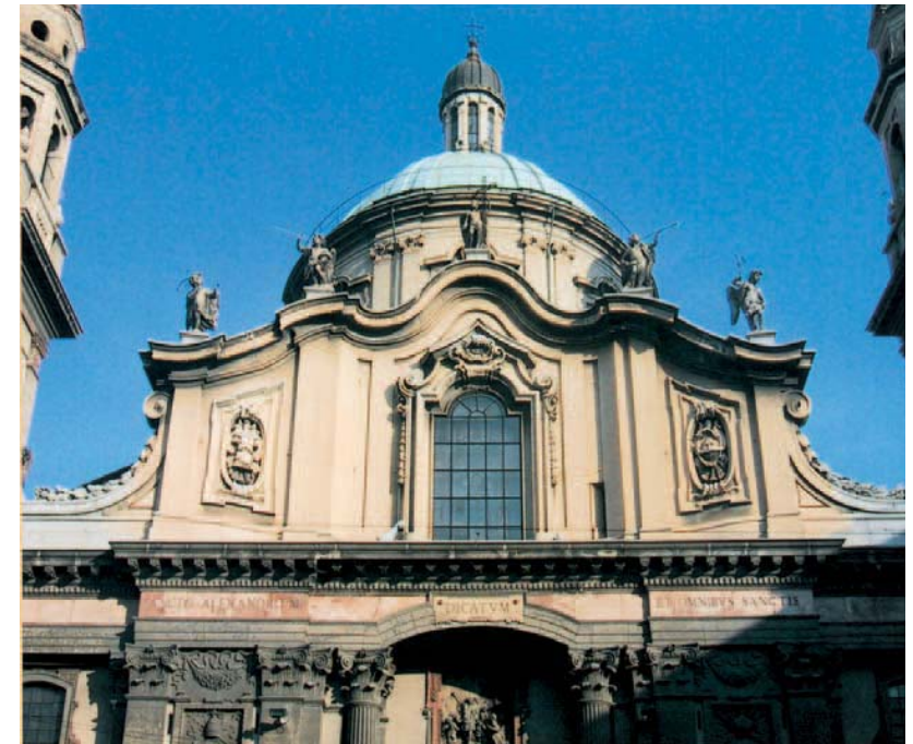
Milan: église Saint Alexandre : partie supérieure de la façade
