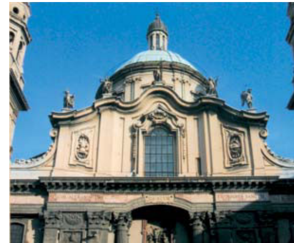
Mailand; Kirche des Hl. Alessandro: oberer Teil der Fassade.
