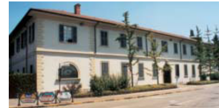
Außenfassade des ersten Internats in Cernusco sul Naviglio.
