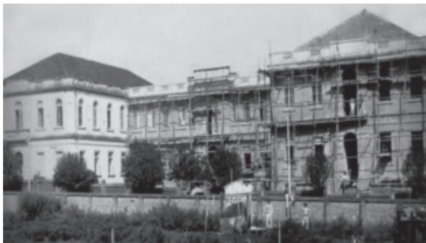
Il nuovo Collegio in costruzione
